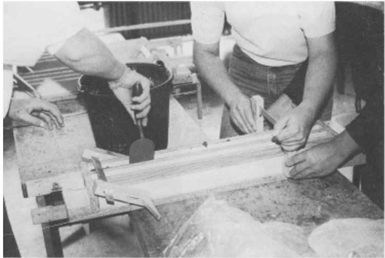
Bild 2: Einfüllen des Betons in die Formen für die Prüfkörper – die Abdeckfolie liegt bereit
